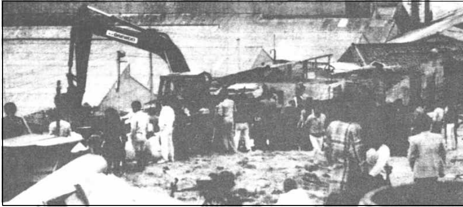
〈학익동 산540번지 철거 현장〉
